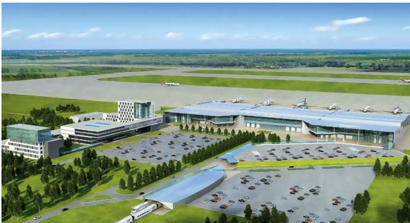
Реконструкция Нижегородского аэропорта
